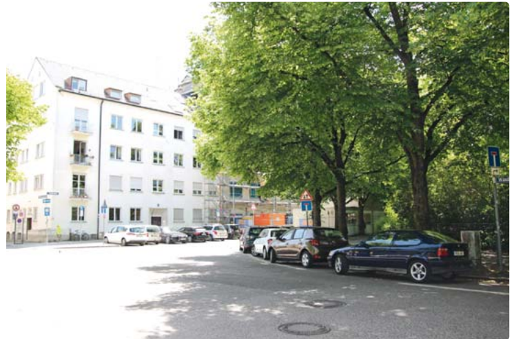
Der BA 9 fordert, dass der östliche Abschnitt der Nibelungenstraße und der Winthirplatz in einem Zug überplant und umgestaltet wird. Bild: sb
