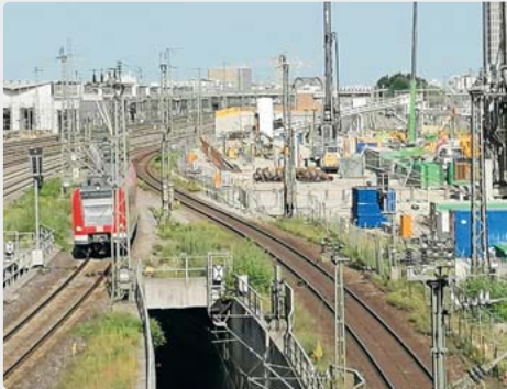
Warnsignale: An der Baustelle der zweiten Stammstrecke werden in den nächsten Monaten auch nachts Warnsignale zu hören sein. Bild: job
