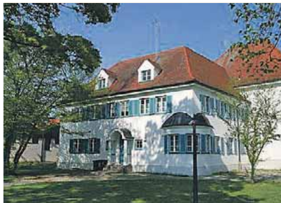
Berglerns Grundschule im geschichtsträchtigen Schulhaus.
