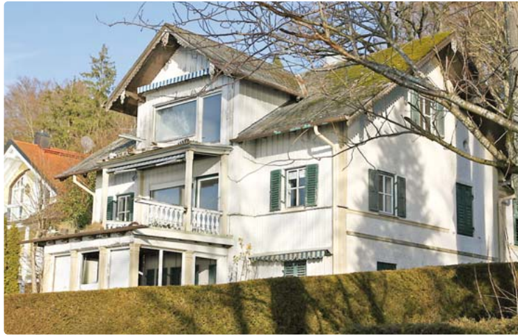
Eine Aufnahme aus dem Jahr 2012. Die Brüstung auf der Veranda ist noch teilweise vorhanden.
