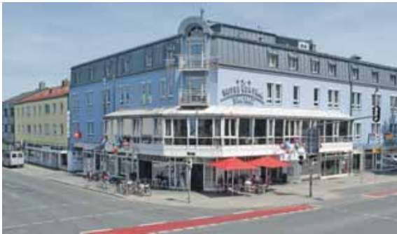
So zeigte sich das Gebäude aus den 90er Jahren bis Anfang der 2020er
