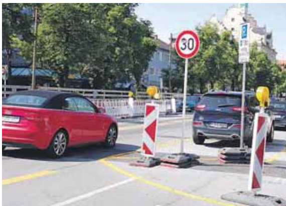
Die Fürstenrieder Straße ist aufgrund der Bauarbeiten für die Tramtrasse seit Monaten eine riesige Baustelle. Foto: Beatrix Köber
