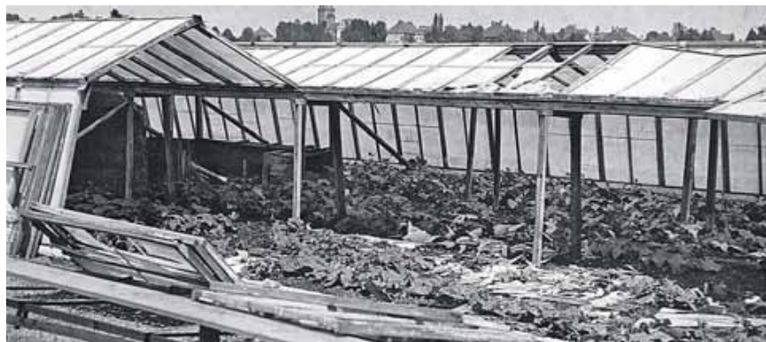
Schlimme Schäden verursachte ein Hagelunwetter über Freising 1984 auch an den Gewächshäusern der HSWT. Foto: bro
