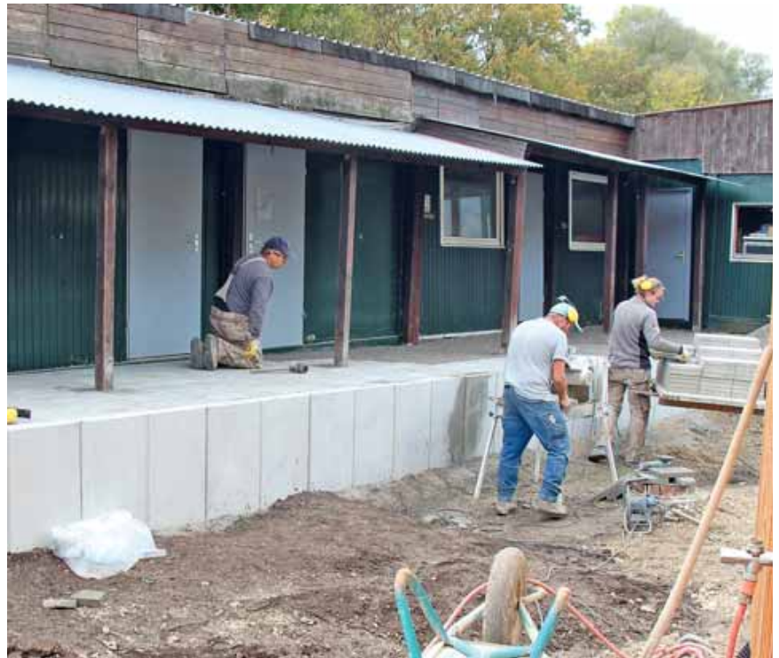
Die Männer von Stefan Gregorzewski arbeiten schon fleißig an den Außenanlagen.
