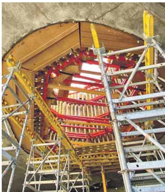
Der Bahnsteig in Martinsried nimmt Gestalt an. Schalungselemente und Durchblick sind gut zu erkennen. Foto: K. Xander
