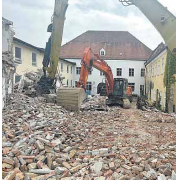
Die Bagger graben sich unermüdlich durchs Geröll. Foto: nsc
