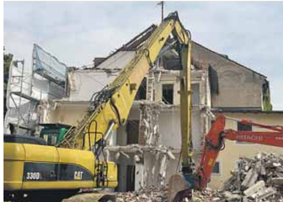
Die Abrissarbeiten in der Rossmayrgasse haben begonnen.
