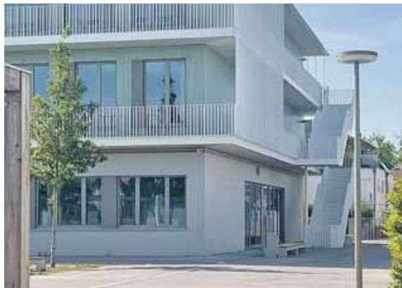
Die Fluchtbalkone sind mit ein bisschen Kletterei übers Türchen und einen Sprint über die Treppen leicht zu erreichen.
