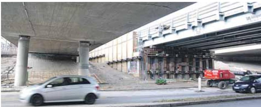
Die beiden Kreuzhofbrücken (links) aus dem Jahr 1966 sind marode und werden abgerissen. Derzeit werden die Behelfsbrücken (rechts) gebaut, über die der Autobahnverkehr während der Neubauezeit fließt. Foto: job
