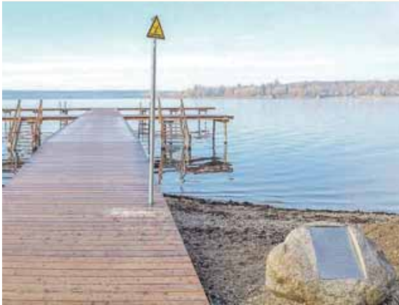
Der neu gebaute Steg mit Spendentafel (rechts).
