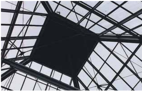
Im Frühjahr werden die Glaspyramiden am Bahnhof Klinikum Großhadern (U 6) instandgesetzt. Foto: job
