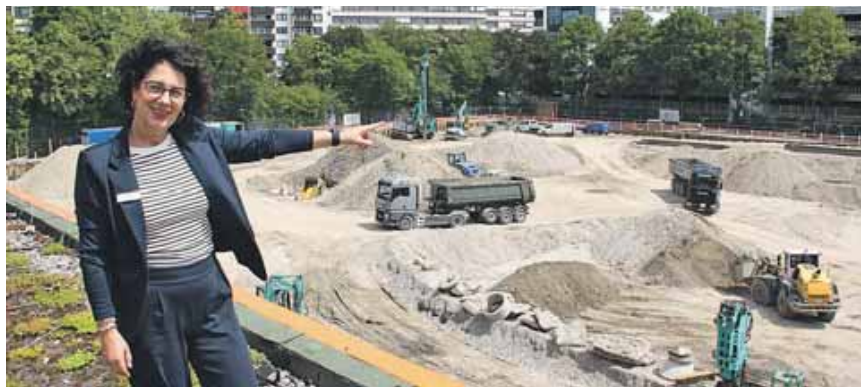
Stv. Marktleiterin Mira Caftanat zeigt vom Dach des V-Markts auf das Baufeld, in dem gerade der Boden abgetragen wird. Dort wird zuerst die Tiefgarage für den neuen V-Baumarkt gebaut. Foto: job
