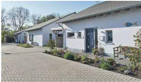
**Massive Einfamilienhäuser aus Leichtbeton-Mauerwerk: Rein mineralische Leichtbeton-Wände gelten als »nicht brennbar« und vermindern die Verbreitung von Rauchgasen.**
