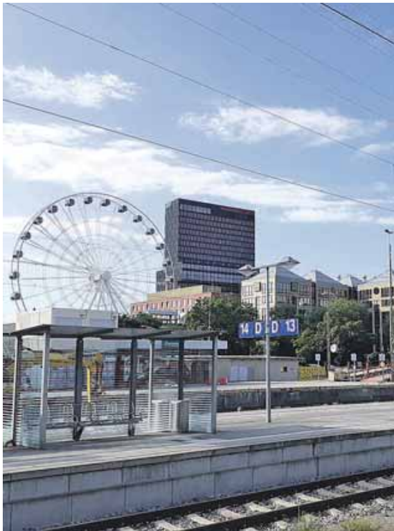
Die neu entstehende Station am Ostbahnhof soll auch vom Werksviertel barrierefrei zugänglich sein. Foto: mha
