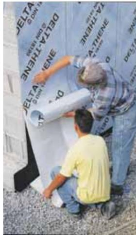
Mit einer kaltselbstklebenden Abdichtungsbahn lassen sich erdberührte Keller-Außenwände sicher abdichten..
