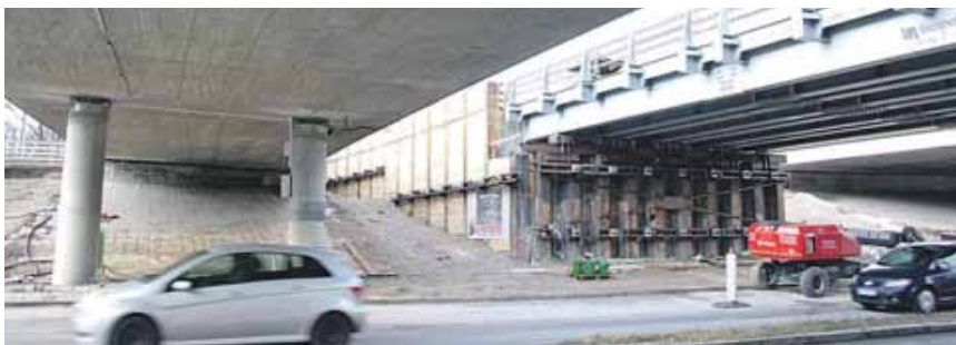
Die beiden Kreuzhofbrücken (links) aus dem Jahr 1966 sind marode und werden abgerissen. Derzeit werden die Behelfsbrücken (rechts) gebaut, über die der Autobahnverkehr während der Neubauezeit fließt.
