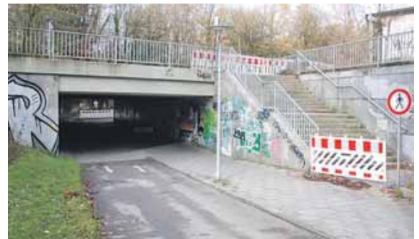
2025 wird die Waldfriedhofunterführung abgebrochen.
