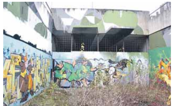
2025 wird der alte Trambahntunnel an der Boshetsrieder Straße verfüllt.
