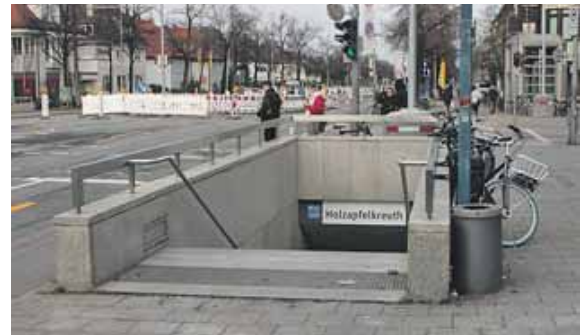
2025 wird der südöstlichen Zugang zum U-Bahnhof Holzzapfelkreuth abgebrochen und neu gebaut.
