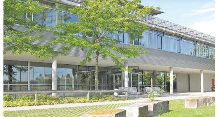
Das Schulgebäude in der Bergsonstraße 109.
