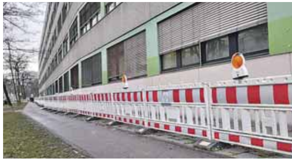
Auf der Westseite der Trappentreustraße, zwischen Gollier- und Westendstraße, bleibt die provisorische Wegeführung vorerst bestehen. Foto: Beatrix Köber
