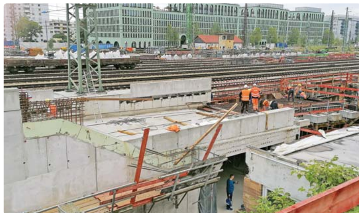
Beim Bau der Umweltverbundröhre wird auch die Laimer S-Bahn-Station neu errichtet. Bild: job
