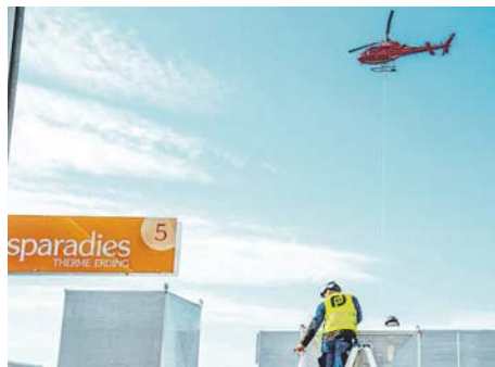
Bauteile für die Thermensanierung schwebten per Heli ein.
