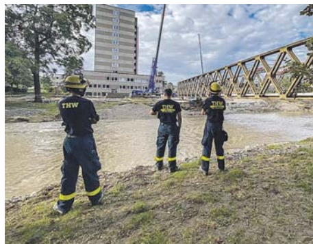
Freisinger THW-Helfer waren maßgeblich am Brückenbau über die Ahr beteiligt. Foto: THW
