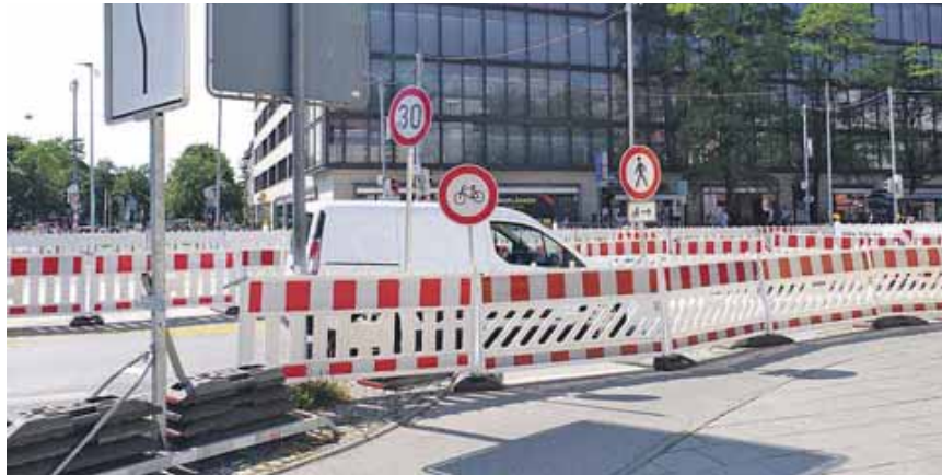
In der Fürstenrieder Straße gelten aufgrund der Großbaustelle für die Tram-Westtangente derzeit viele einschränkende Regelungen im Straßenverkehr. Foto: Beatrix Köber
