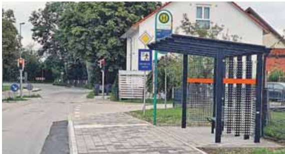
Die Bushaltestelle »Gewerbegebiet Argelsried« ist jetzt barrierefrei. Foto: Gemeinde
