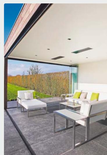
Flache Dunkelstrahler werden stilvoll direkt an der Decke montiert.
