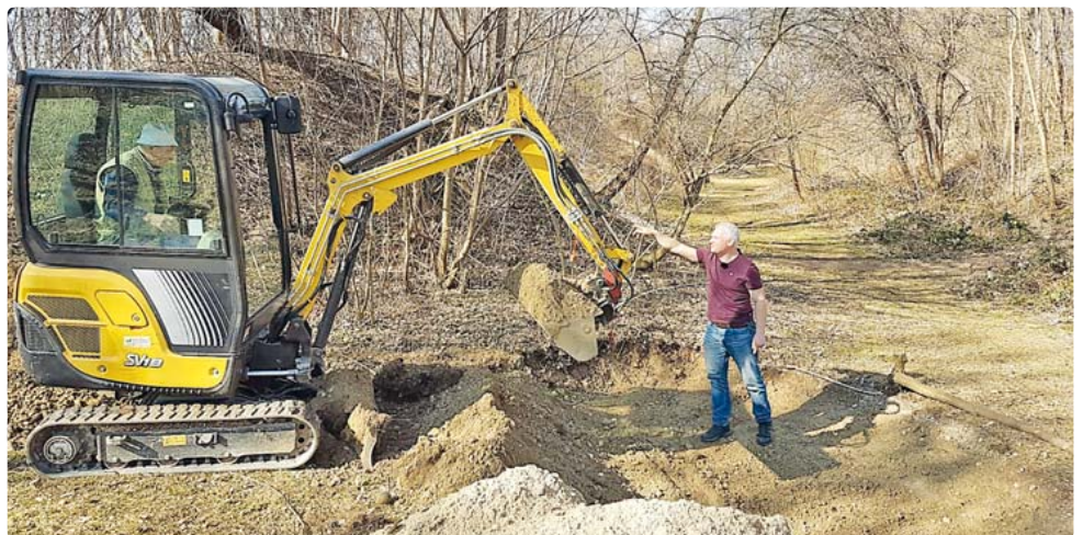
Hier entsteht ein neues Zuhause für Frösche.
