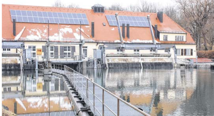
Mit dem Münchner Ferienpass erleben Kinder und Jugendliche z.B. einen informativen und spannenden Rundgang durch die historische Laufwasserkraftanlage „Isarwerk 2“, die am Fuße des Flauchers im Stadtbezirk Sendling zu finden ist. Bild: job
